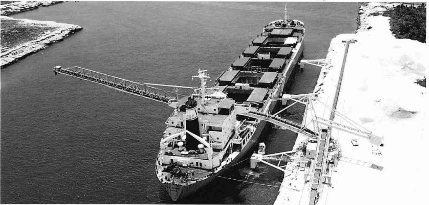
Carga del centésimo embarque en el puerto de Calica; abajo: banda transportadora en operación. Página opuesta: almacenamiento del material.
